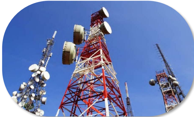
Antenas de Telecomunicaciones
